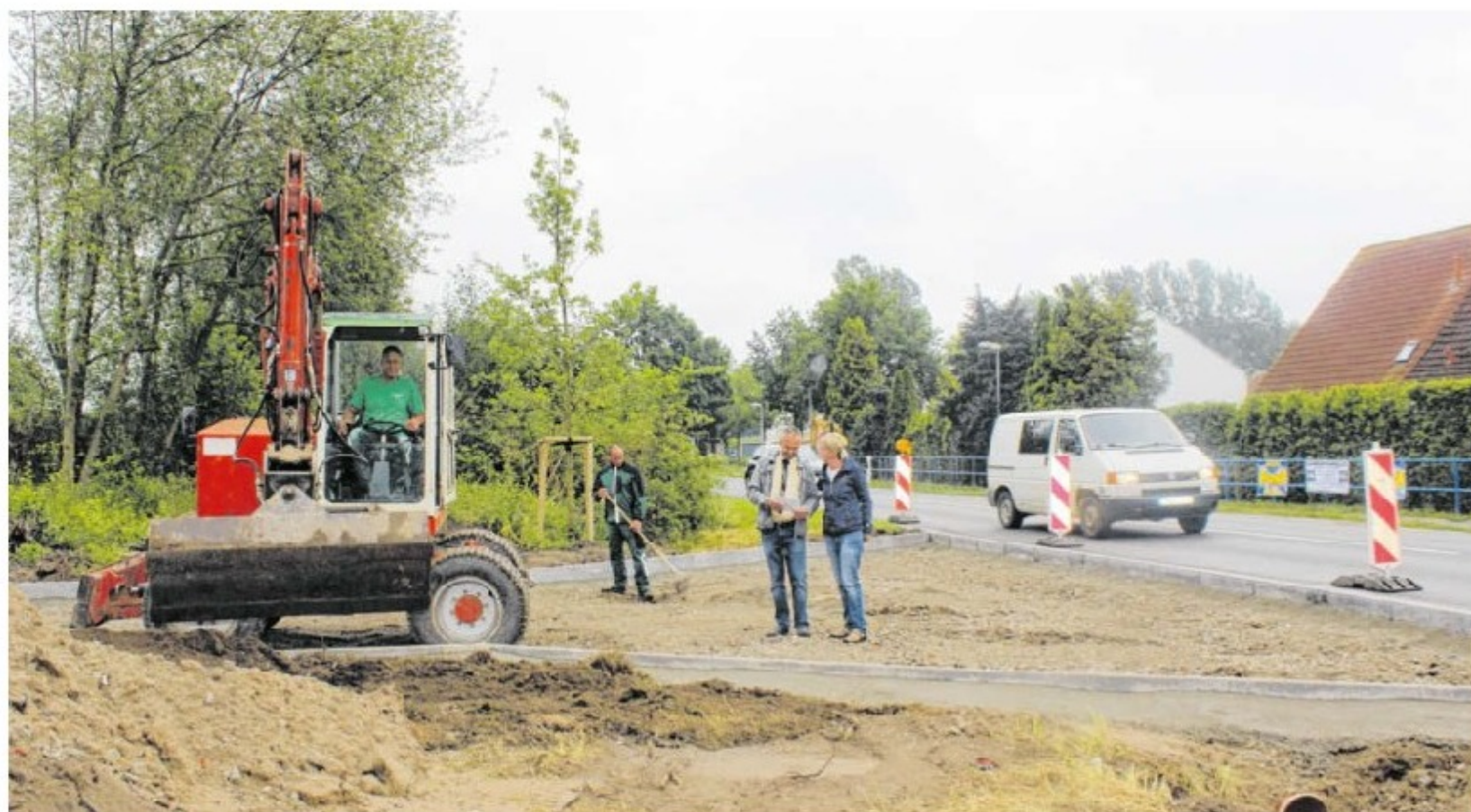
An der Wolgaster Landstraße entsteht eine neue Zufahrt zum Campingplatzgelände.
